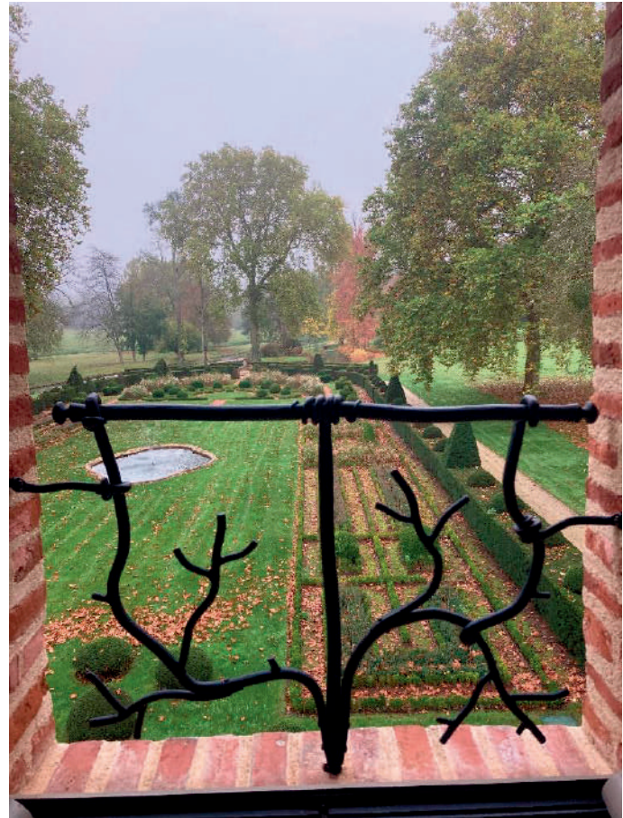
Garde-corps (cliché R. Barré)
