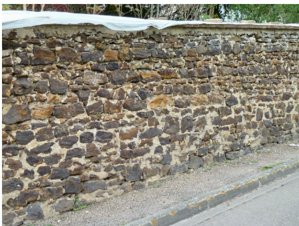
Enduit à pierre vue : avant et après travaux
