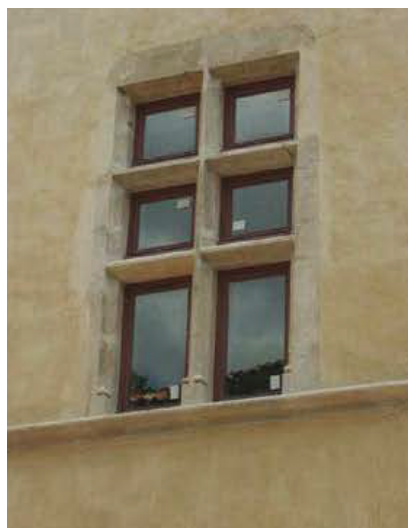
← Enduit fin et tendu sur sa maçonnerie, bien arrêté sur les pierres d'encadrement des baies
