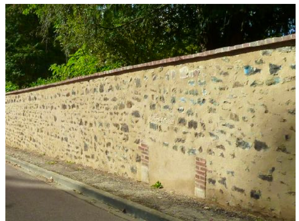
Enduit à pierre vue : avant et après travaux
