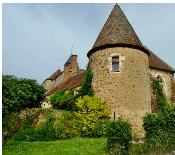
← Enduit fin et tendu sur sa maçonnerie, bien arrêté sur les pierres d'encadrement des baies
