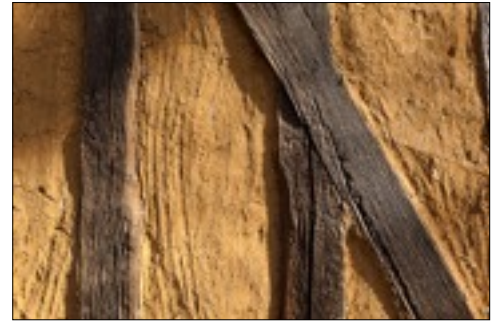
Au CFA, un essai de torchis datant d'une quinzaine d'années
